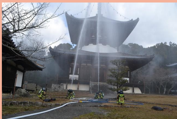
消防隊が延焼拡大する大塔へ消火活動
