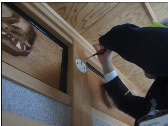
ベースの取付け
