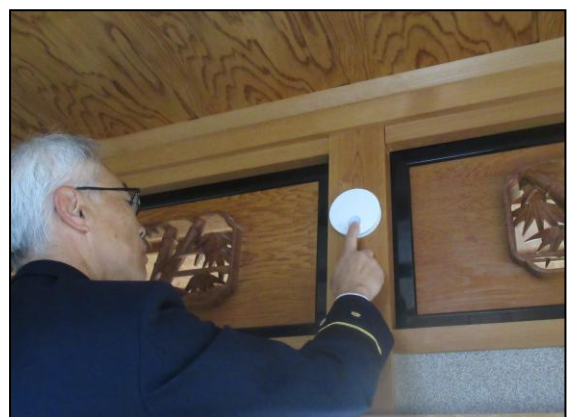
設置完了・作動確認
